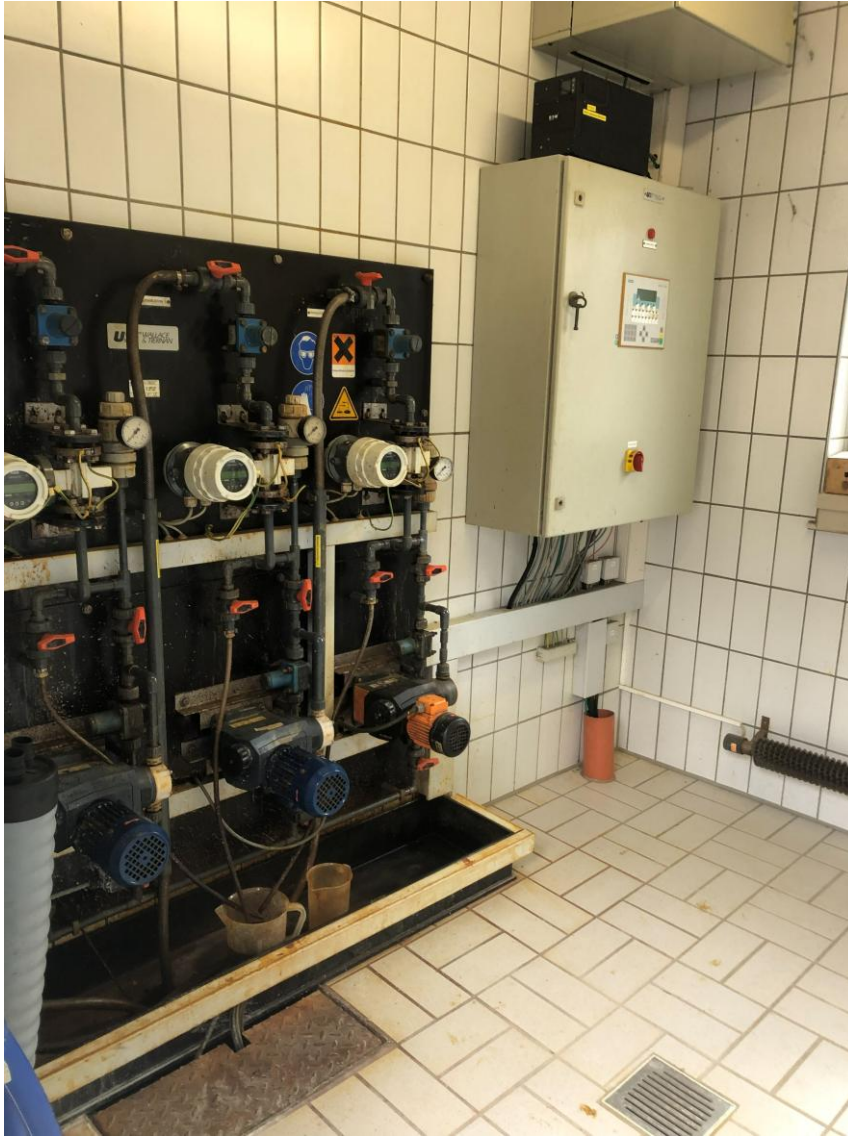
Abbildung 3: Aufstellung Dosiertechnik, Schaltanlage
