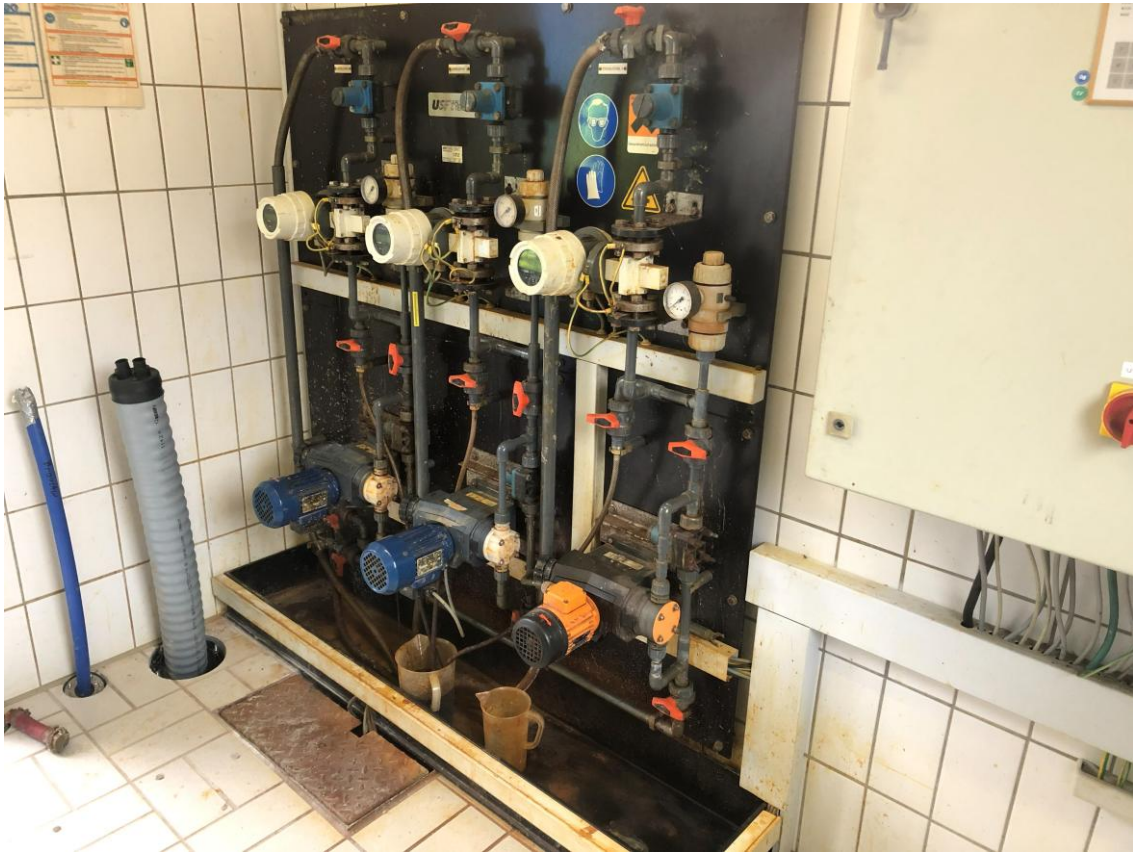
Abbildung 1: Bestehende Dosiertechnik
